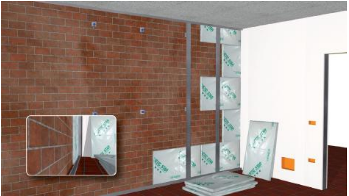
5) Vkladanie izolačného materiálu do dutiny.
